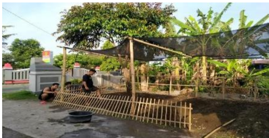
Gambar 2. Menunjukkan pembersihan lahan yang di kerjakan oleh Tim KKN.
